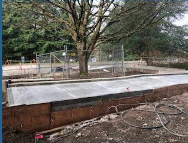
West side exterior ADA ramp – Pour in progress
